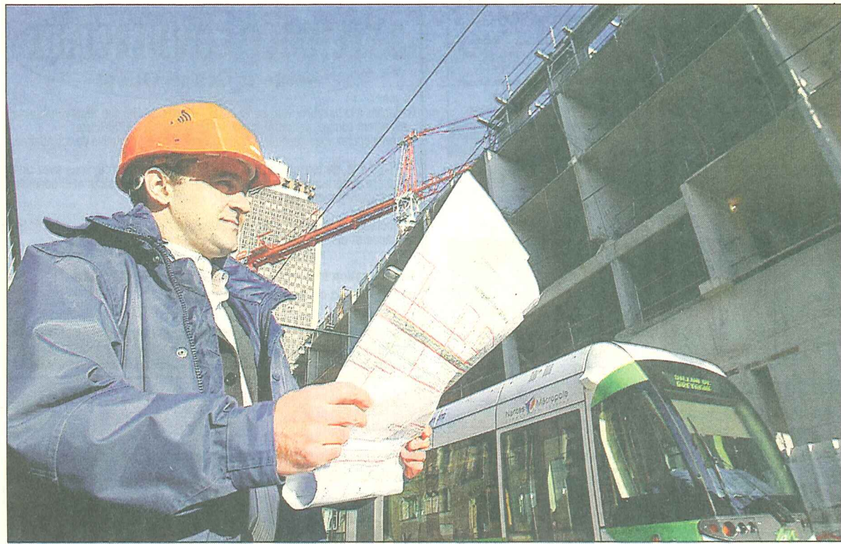
Le bureau de Fabien, ingénieur bâtiment, est toujours installé au cœur du chantier qu'il suit jour après jour.
